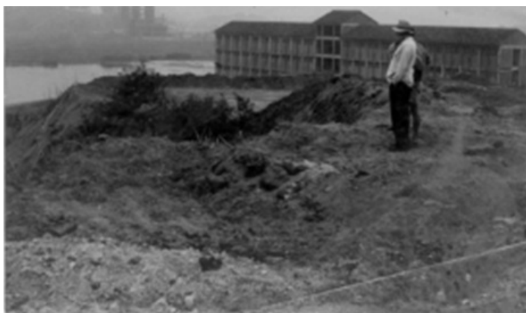
Figura 3 Construção do presídio
