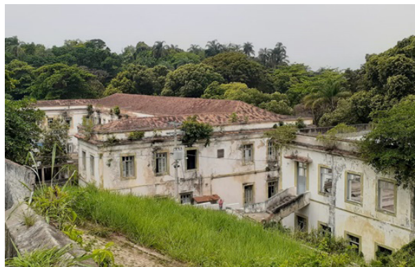
Figura 8 Vegetação em prédios históricos
