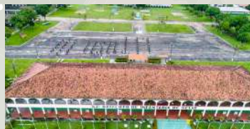
Pavimentação do 53º Batalhão de Infantaria de Selva em Itaituba (PA).
