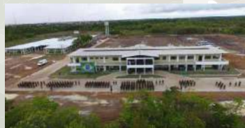
Obras de Infraestrutura da 22ª Brigada de Infantaria de Selva em Macapá (AP).
