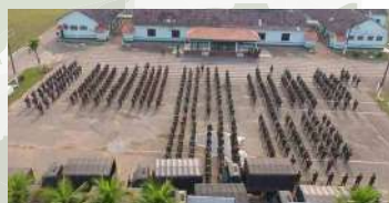
Construção da Infraestrutura da 17ª Brigada de Infantaria de Selva em Porto Velho (RO).
